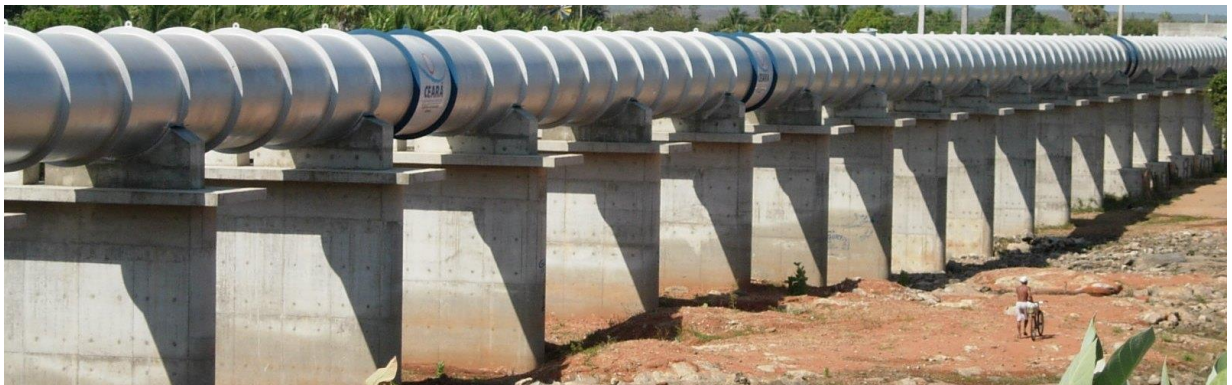
Ramal do Agreste — adutora, Ceará
