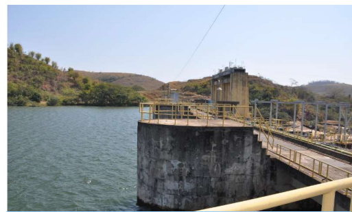
Vista da comporta K do Vertedouro do Canal Norte
