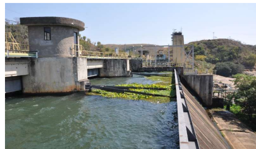
Detalhe do reservatório da barragem a montante do Vertedouro do Canal Norte
